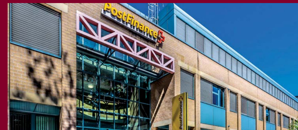
→ Office PostFinance AG Bern żagle sufitowe
