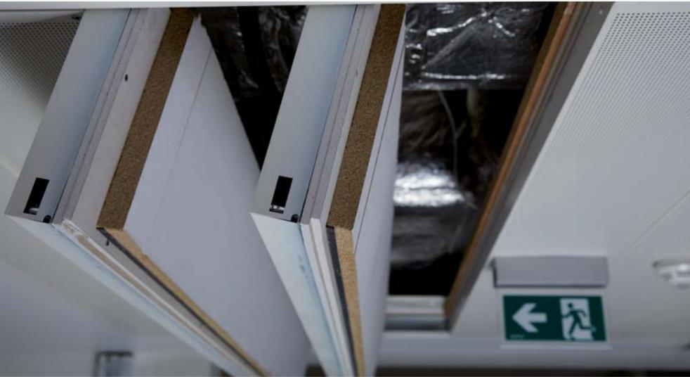
Das neue Brandschutzdeckenhandbuch Schweiz vereint alle für den Brandschutz wichtigen Informationen. Das Abklappsystem EI 30 und das Abklappsystem EI 60 werden detailliert behandelt: Aufbau, Wandanschlüsse, Mittelabhängungen, Flurkreuzungen, Nischenanschlüsse, Friesanschlüsse, Mittelfriese, Montagerichtlinie und Nutzerrichtlinie.
