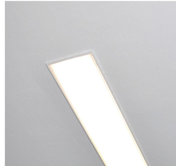
Sauberer Anschluss an GK-Platte durch Leuchtenrahmen
