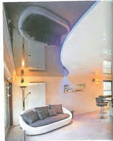
Das farbige LED-Leuchtband trennt die beiden Deckenbereiche
