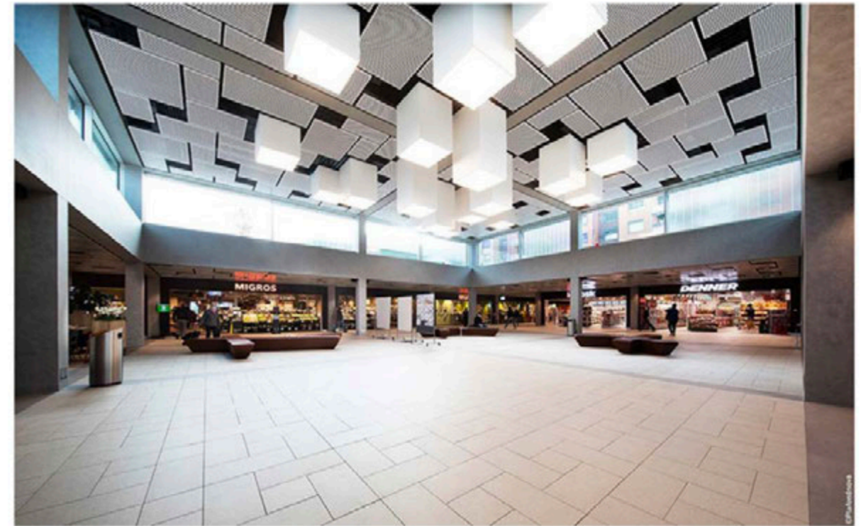
Metalldecken im Einkaufszentrum Herti, Schweiz. Bildquelle: Plafondnova
