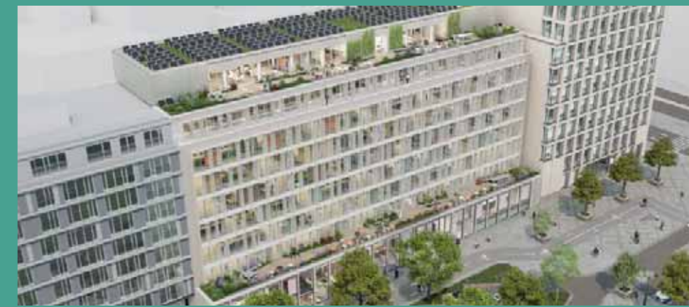
→ Regence 52 Bruxelles, BE Plafond rafraîchissante
