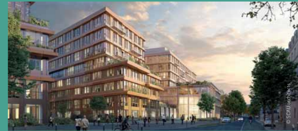
→ Campus ENGIE Paris, FR Plafond rafraîchissante
