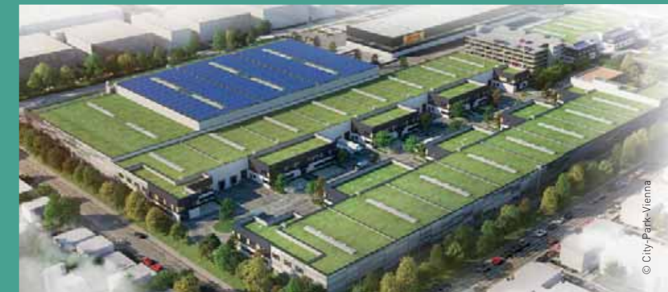
→ City Park Wiedeń, AT sufit chłodzący
