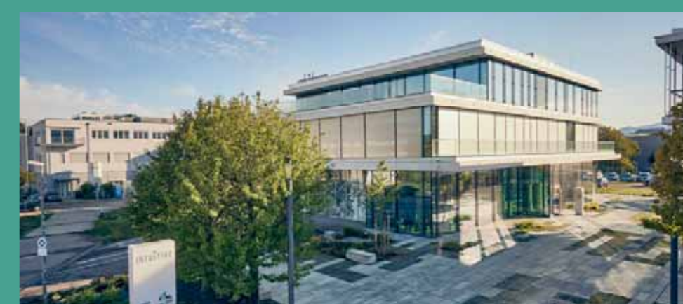
→ Intuitive Surgical Deutschland Freiburg, DE Deckensegel
