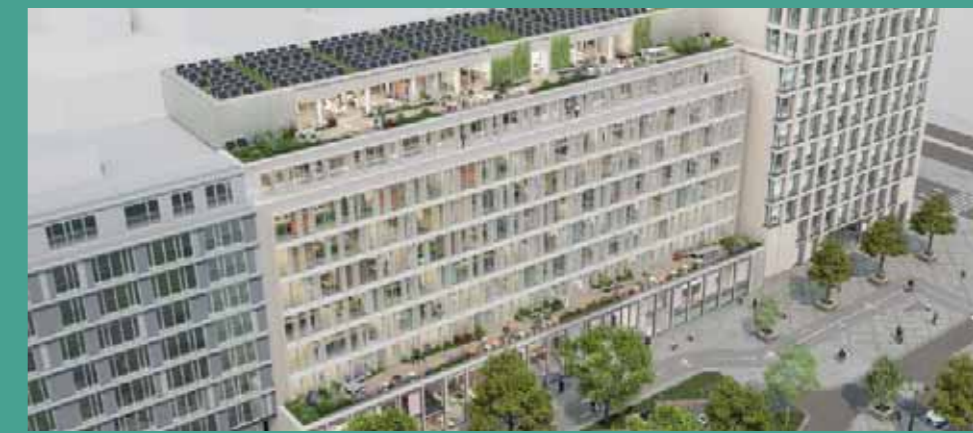
→ Regence 52 Brussel, BE Kühldecke (nur Kassetten)
