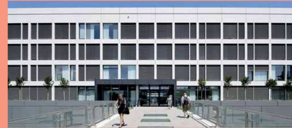
→ Health CH Hôpital de la Tour Meyrin Protection incendie
