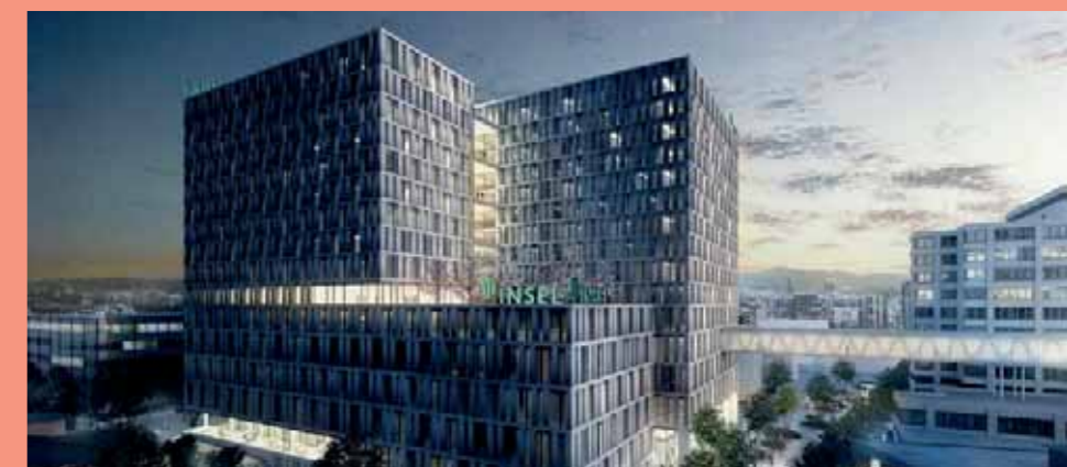
→ Health CH InselSpital Bern Îlot de plafond
