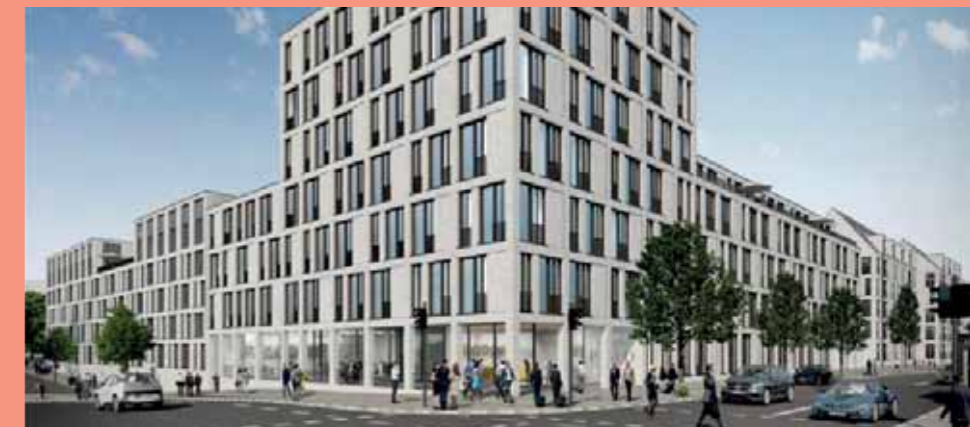
→ Office DE Paseo Carré Munich Plafond rafraîchissant
