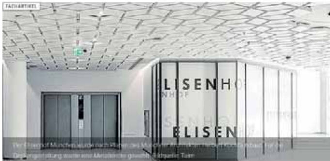
Der Elisenhof in München wurde nach einem der größten Umbau- und Sanierungsprojekte in Deutschland. Die Langzeitnutzung wurde von Metalldecken gewährleistet. Quelle: Taim
